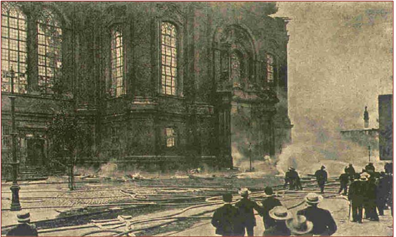
Löscharbeiten am Portal
