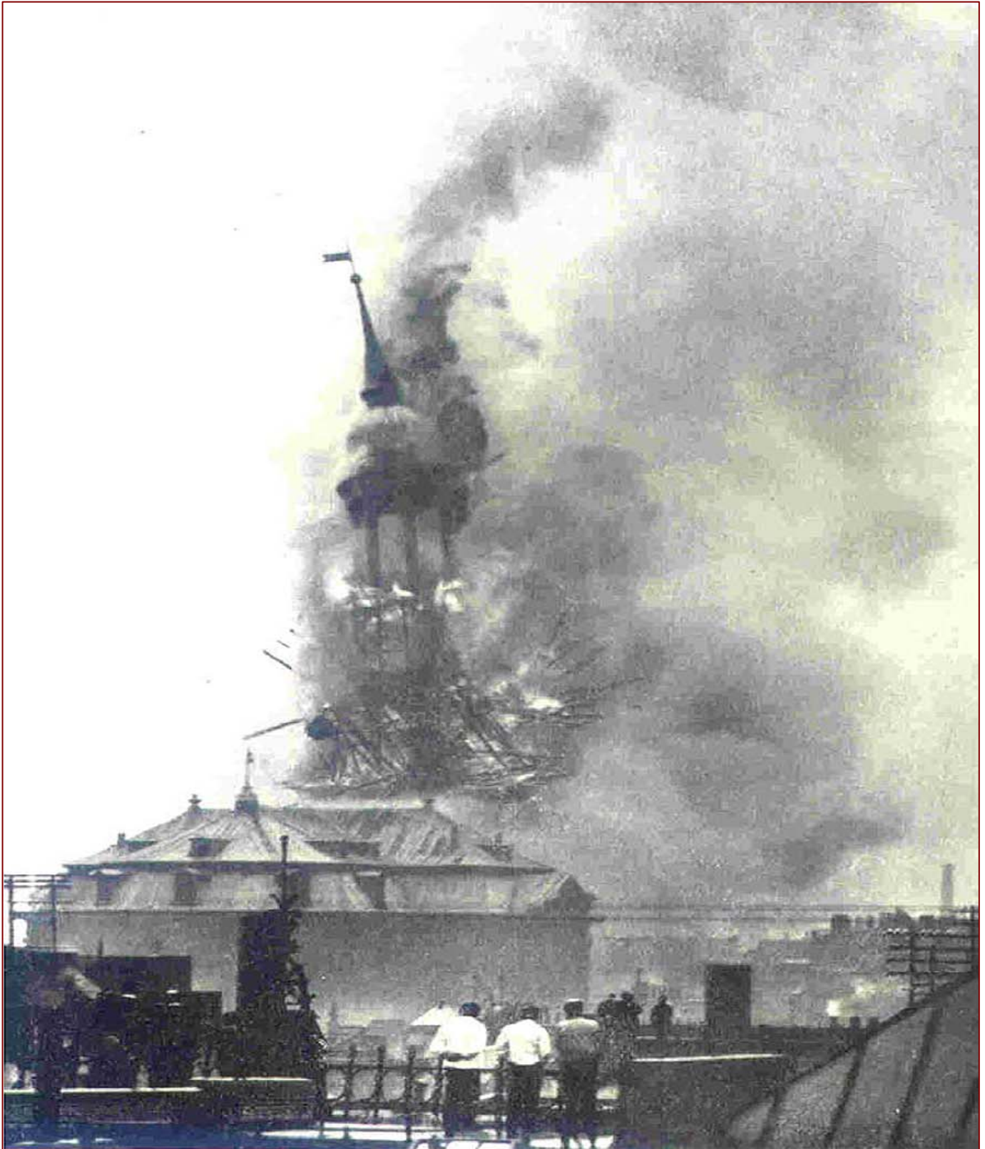
Die Hauptstützen brechen zusammen, der Turm stürzt ein (Ostseite am 3. Juli 1906 um 15:07 Uhr)
