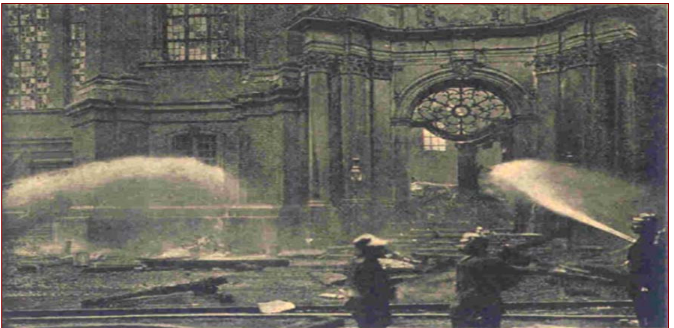
Nachlöscharbeiten in der ausgebrannten St. Michaeliskirche
